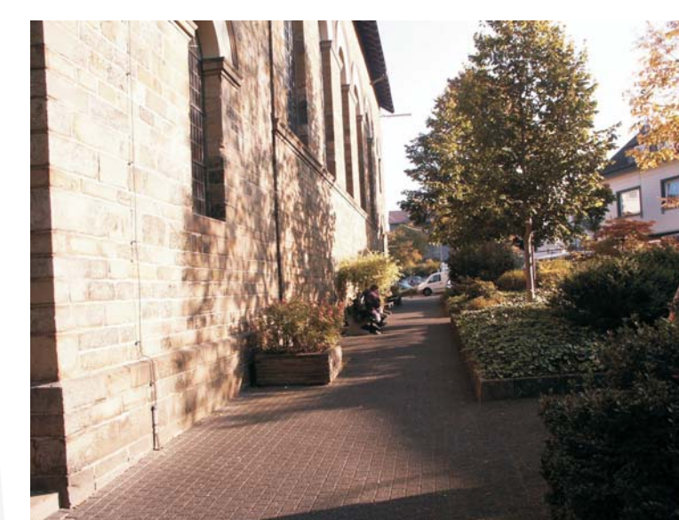
SÜDFASSADE MIT AUSSENANLAGE
